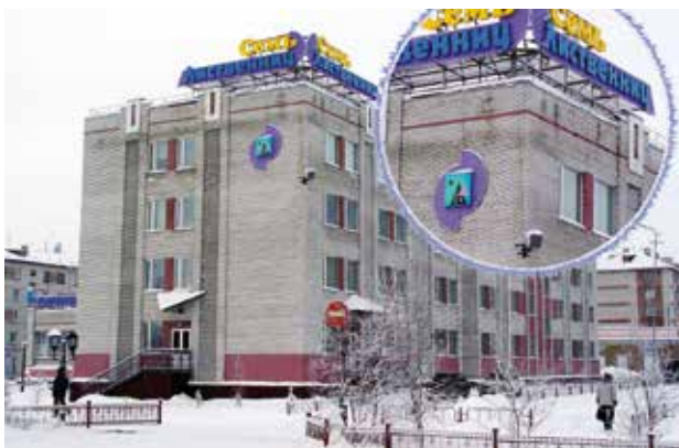
Системы уличного оповещения, г. Лабитнанги, 2005 год
